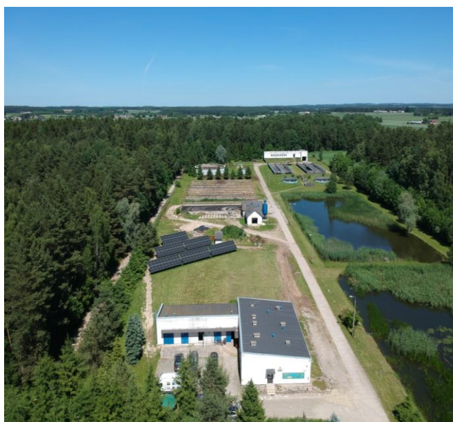
Instalacja fotowoltaiczna o mocy 44,04 kWp – miejska oczyszczalnia ścieków
