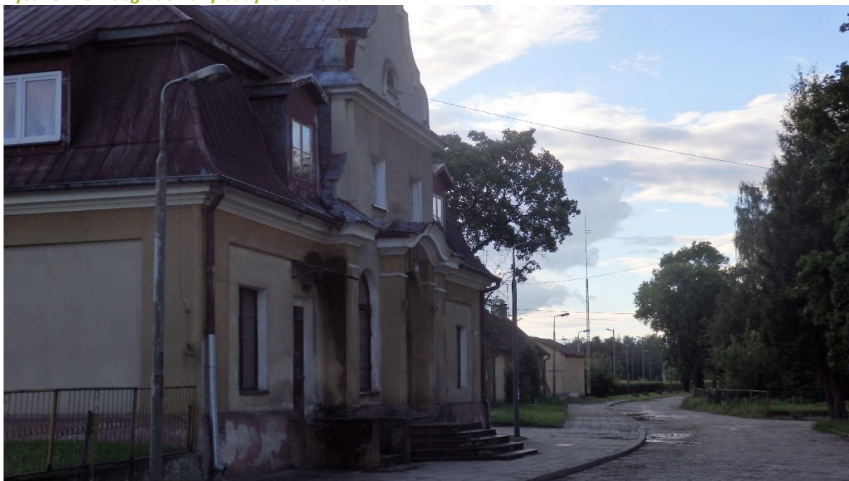
Rysunek 26. Zdegradowany budynek dworca PKP
